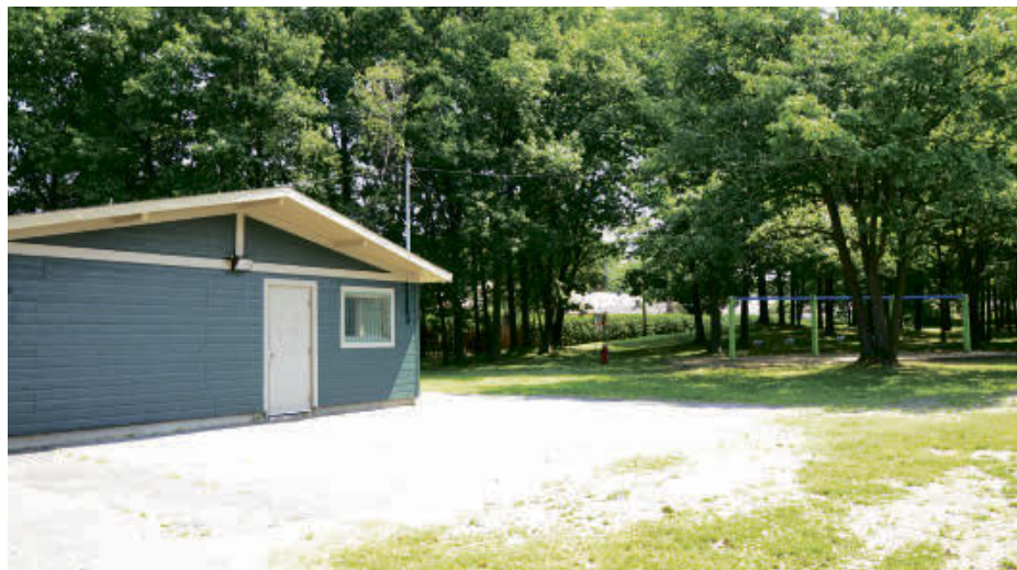
Le chalet de service du parc des Trembles sera rénové. (Photo : Archives)
