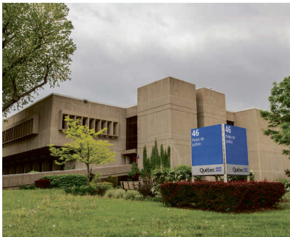
Les travaux seront effectués d'ici juin 2018 au palais de justice de Sorel-Tracy.
