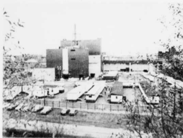
D'ici quelques jours, on entamera la phase de prédémarrage de la nouvelle usine de fluorure. Quantités de vérifications et d'ajustements seront effectués sur les équipements de façon graduelle au cours des prochains mois. (Photos: Germain Bonneau).
