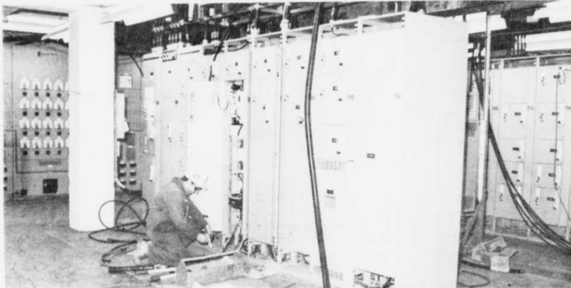
Parmi les quelque 450 employés à l'oeuvre, un électricien travaille au câblage électrique dans la salle de contrôle des moteurs.
