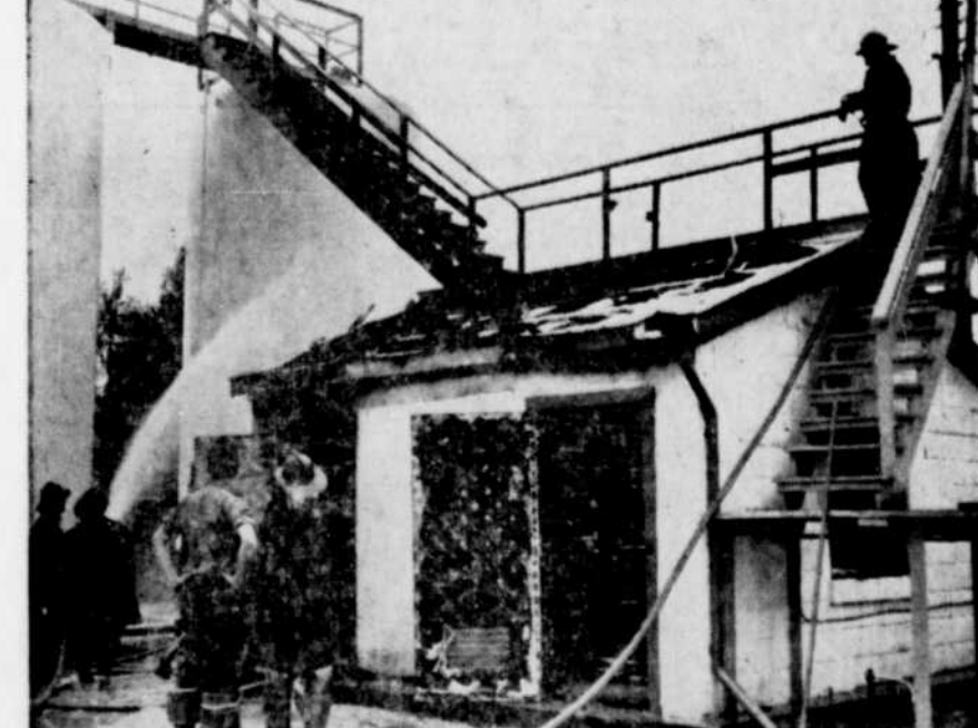
Essence. — Cette photo donne une excellente idée de la disposition des lieux du dépôt d'essence, à l'angle des rues King ouest et Quatre Pins, où un incendie s'est déclaré, vers 3 h. 15, hier après-midi. On remarque que la bâtisse qui abrite le système de pompage est située à 12 pieds des réservoirs d'essence. De plus, on note aussi que l'escalier qui conduit au haut des réservoirs a été endommagé par les flammes. L'intervention des pompiers a toutefois été assez rapide pour éviter toute explosion. (Photo La Tribune)
