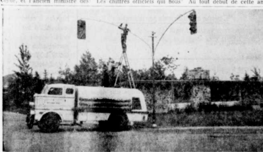
Signaux lumineux modernes. — Le département de la circulation de la cité de Magog a installé récemment des signaux lumineux très modernes, au coin des rues Des Pins, Percy et Bowen. Des employés mettant la dernière main à l'installation.
