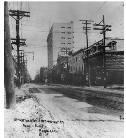
43. Vue vers l'est depuis l'intersection des rues Sainte-Catherine et Sanguinet; à l'arrière-plan, l'immeuble Dandurand, 1914.
