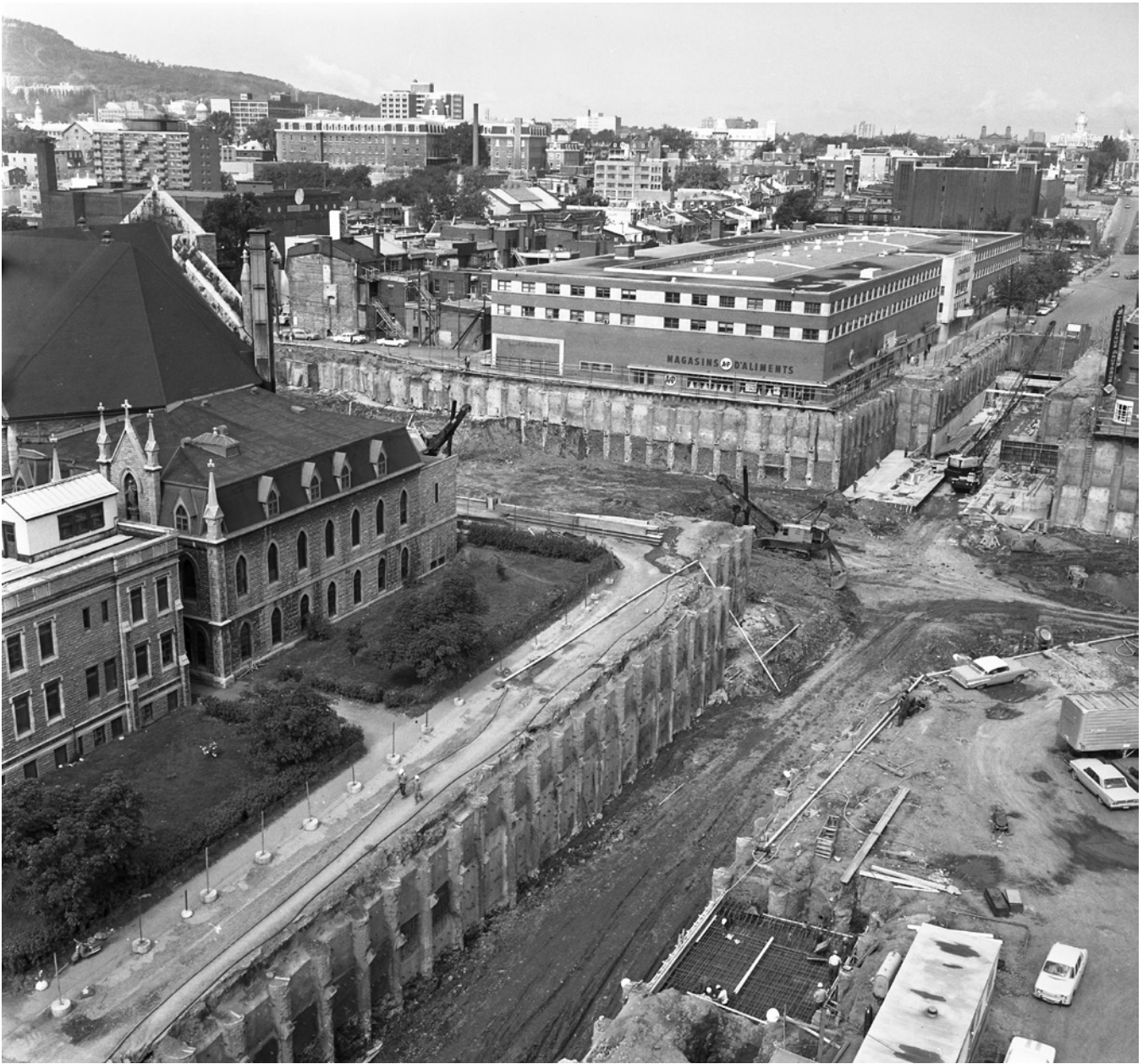
48. Construction en trémie de la station de métro Berri-De Montigny en 1964, au carrefour des rues Berri et De Montigny (aujourd'hui le boulevard De Maisonneuve).
