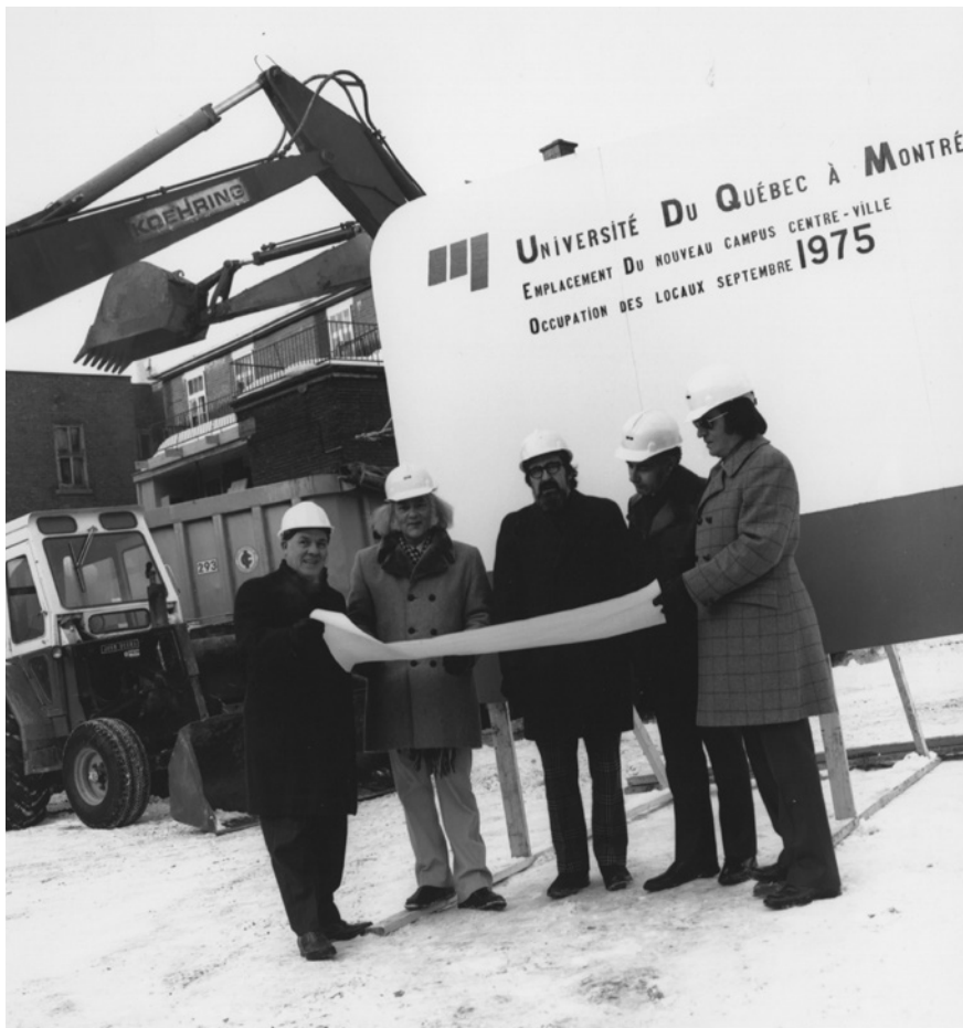
89. Le recteur de l'UQAM, Léo A. Dorais, au centre, visite le chantier de la phase 1 du campus vers 1974.
