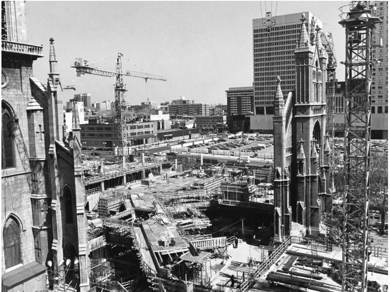
96. Le pavillon Judith-Jasmin, en construction, en 1977.
