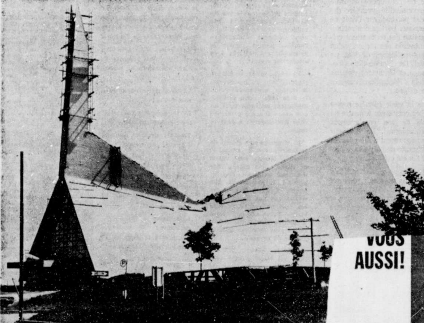
NOUVELLE EGLISE EN CONSTRUCTION SUR LA ROUTE DE L'EGLISE, A STE-FOY, St-Denis-du-Plateau. Les travaux doivent se terminer pour le début de novembre prochain. (Photo L'Action Marcel Laforce)
