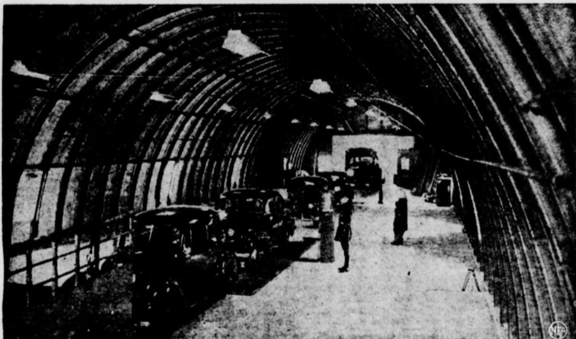
La "parade de sûreté" se déroule devant les stations d'essai. On est ici à éprouver les freins de la troisième voiture.
