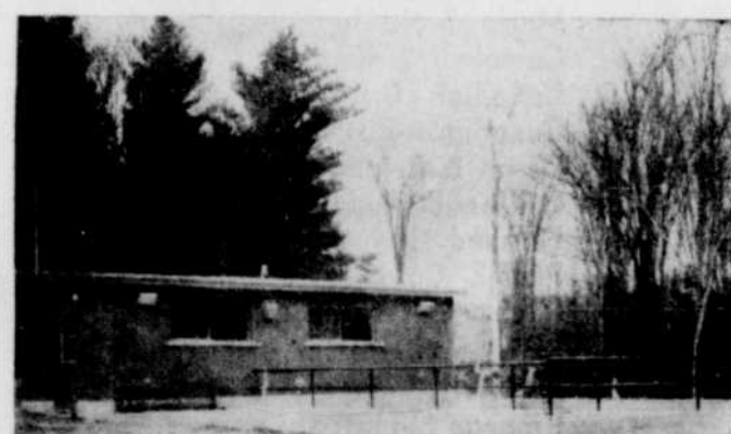
Ci-dessus, l'usine d'épuration des eaux-vannes, pouvant desservir 1500 personnes.
