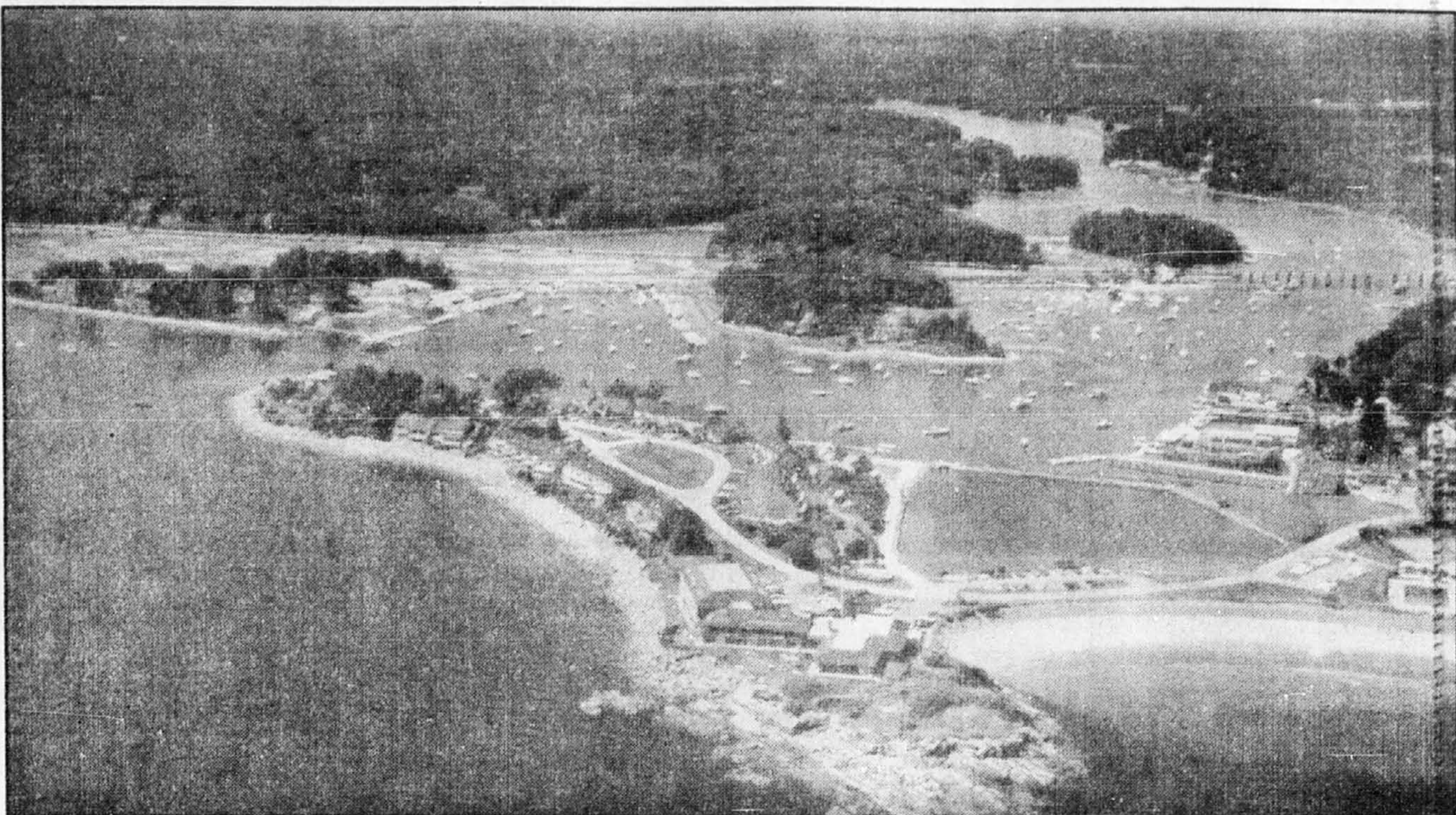
Une vue aérienne de York Harbour. Sur la presqu'île, les installations du Stage Neck Inn. À droite, l'une des plages des Yorks.
