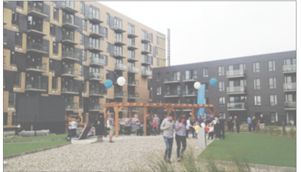
Quartier QB – la nouvelle ère de vie à Sainte-Foy.
