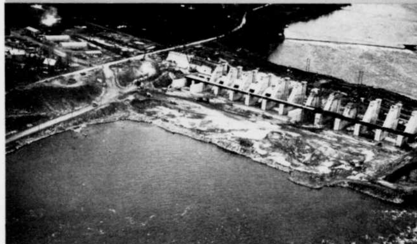
CARILLON. Cette centrale, dont la mise en marche est prévue pour la fin de 1962, est située sur l'Outaouais, à quelque 50 milles de Montréal. Elle doit servir d'usine de pointe, en hiver et d'usine au fil de l'eau, en été et comprendre 14 groupes de 60,000 h.p. chacun. Les explosifs C-I-L ont joué un rôle important à toutes les phases de l'excavation.
