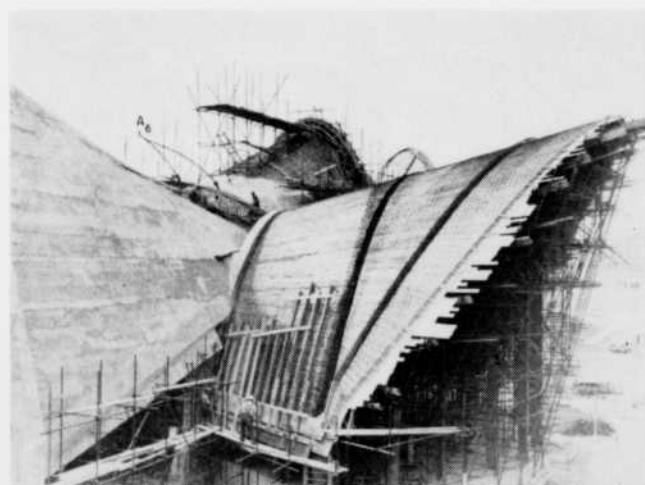
Fig. 5 Détails du transept bétonné en partie, et du ferrailage de l'abside.
