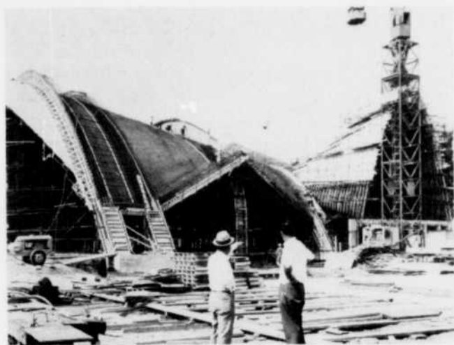
Fig. 6 — Ferrailage de la grande nef et coffrage du transept.
