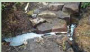
« Barre d'eau » qui permet l'évacuation de l'eau à l'extérieur du sentier.
