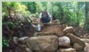
Vérification de la pente latérale du sentier.
