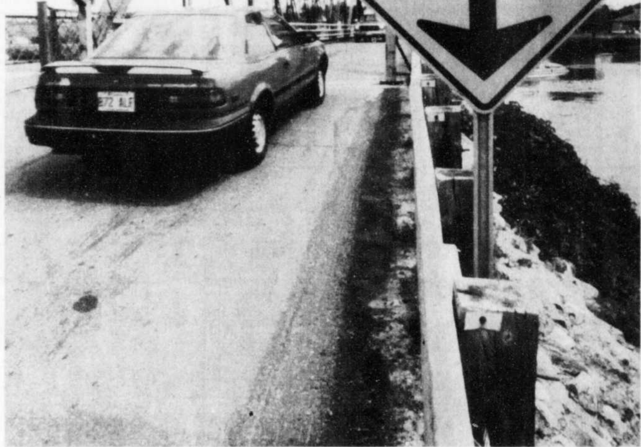
Des balises ont été installées à l'entrée du pont de la route 159, à Saint-Stanislas, pour empêcher le passage de véhicules lourds.
