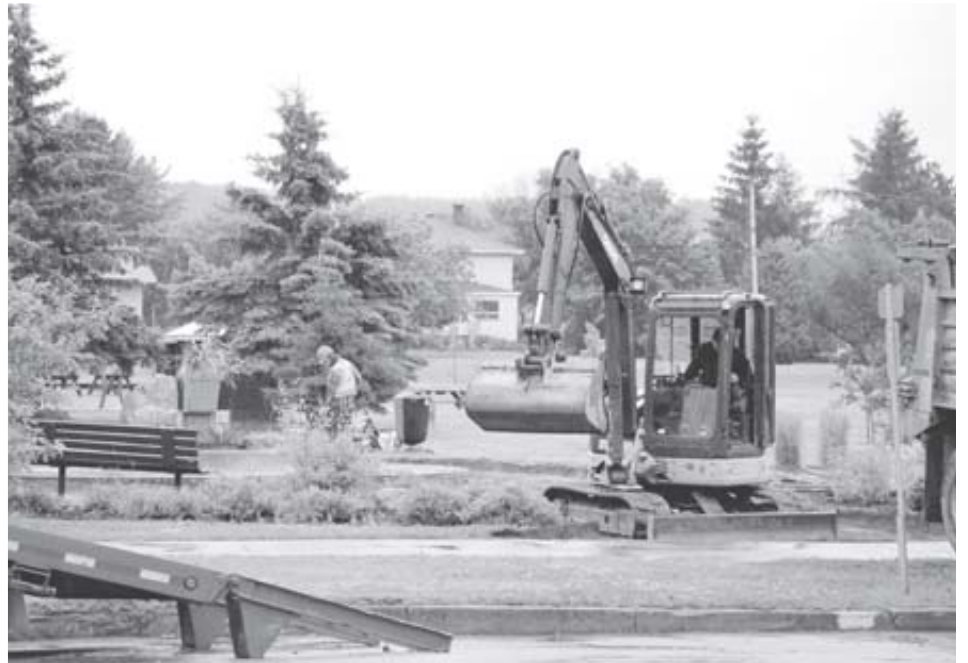
Des travaux ont lieu au Parc Ernest-Ouellet de Saint-Pascal. Photo : Maxime Paradis
