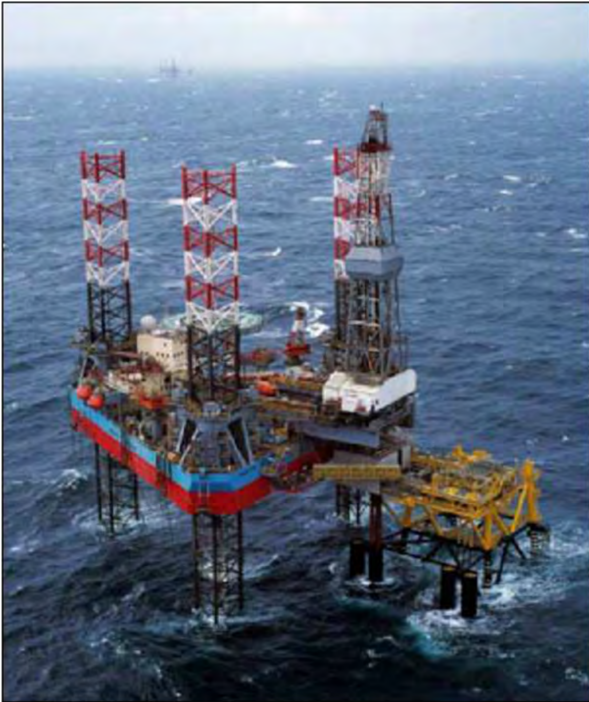
Figure 35 Plateforme de forage autoélevatrice (Bai et Bai, 2012)
