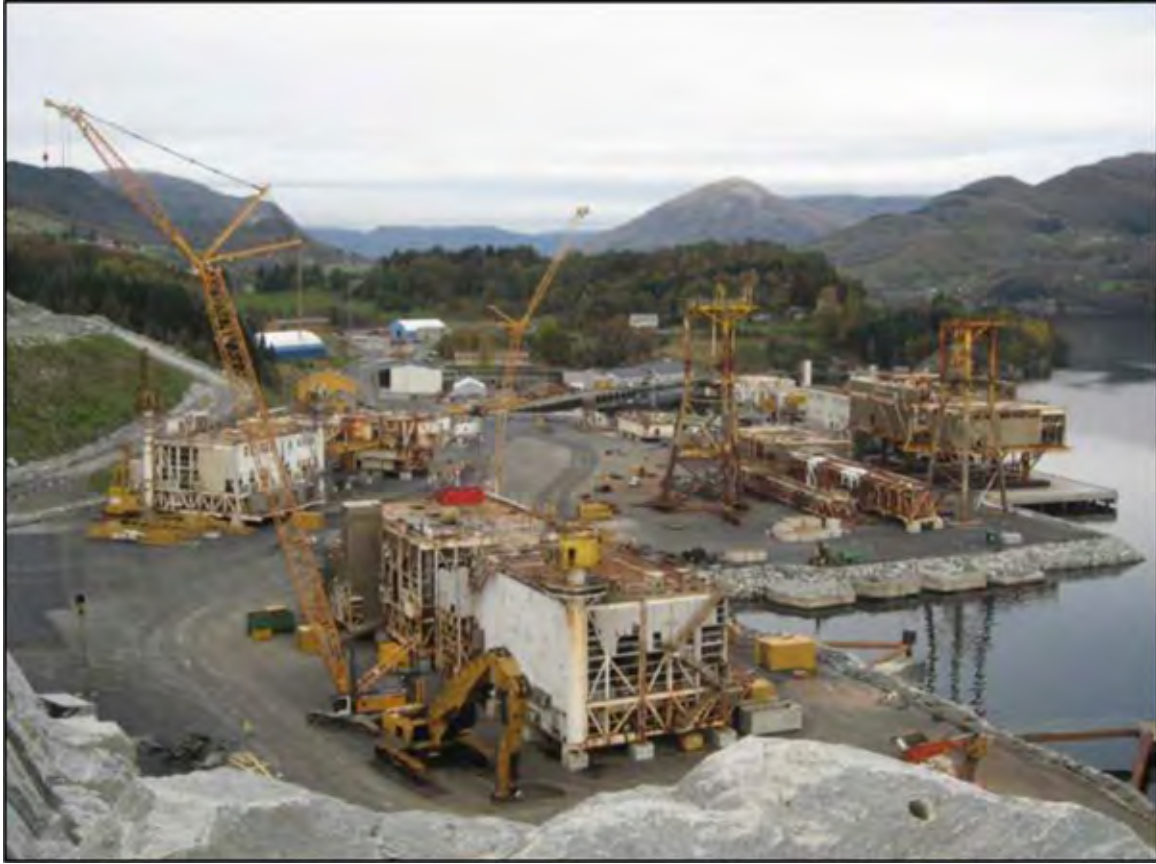
Figure 109 Site de démantèlement de structures extracôtières en Norvège (KLIF, 2010)
