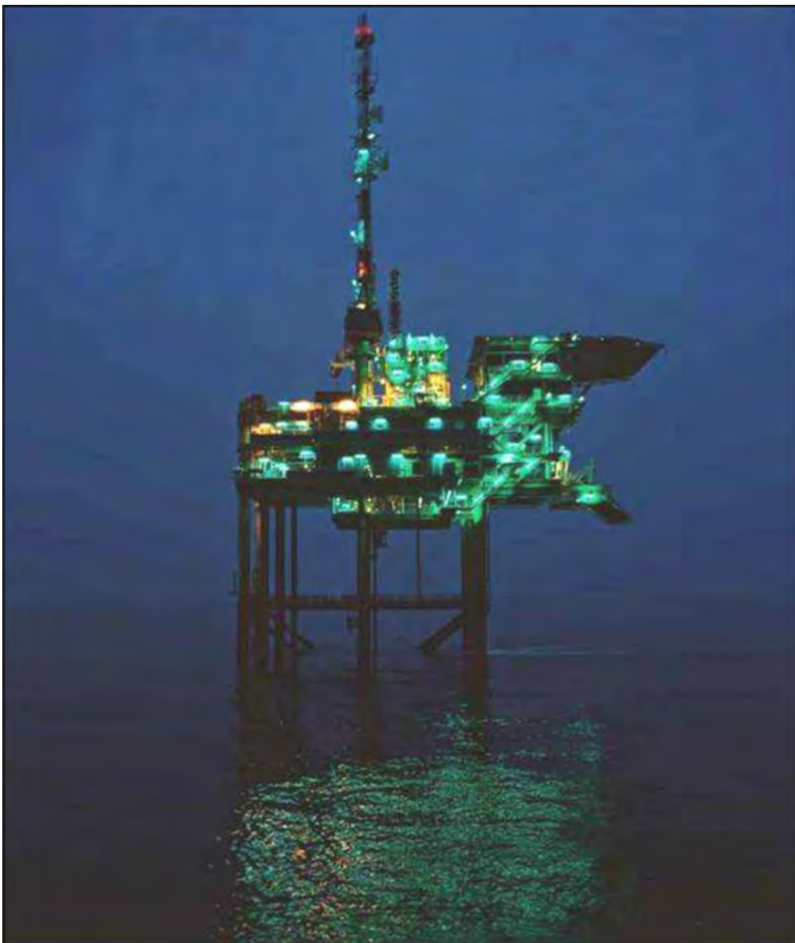
Figure 117 Installation de production de gaz naturel dans la mer du Nord utilisant une lumière verte afin de réduire les impacts sur les oiseaux marins (Poot et al. , 2008)
