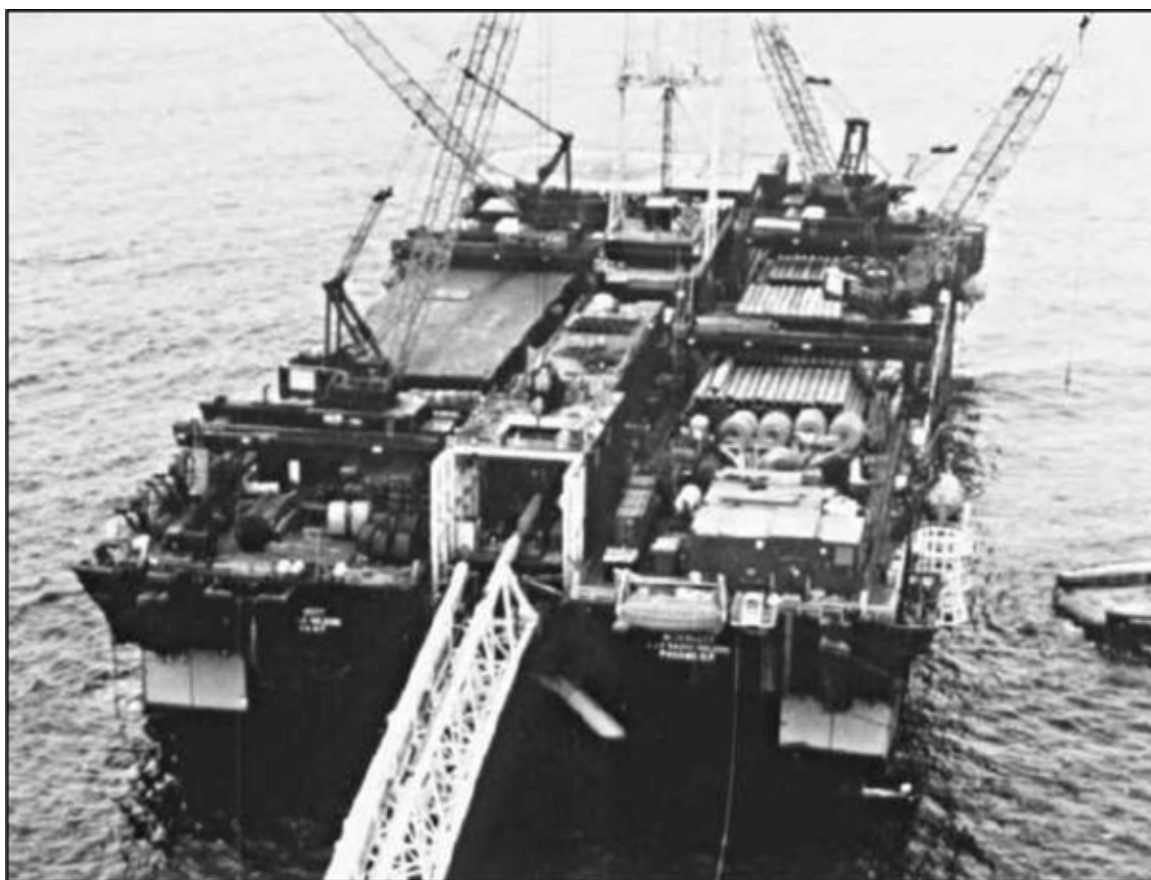
Figure 79 Navire de pose pour l'installation de pipelines sur le fond marin (EnCana, 2006)
