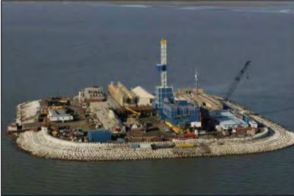
Figure 58 Île artificielle Oooguruk dans le golfe de Cook, en Alaska, utilisée pour l'exploitation en milieu extracôtier avec couvert de glace (DeGeer et al., 2012)
