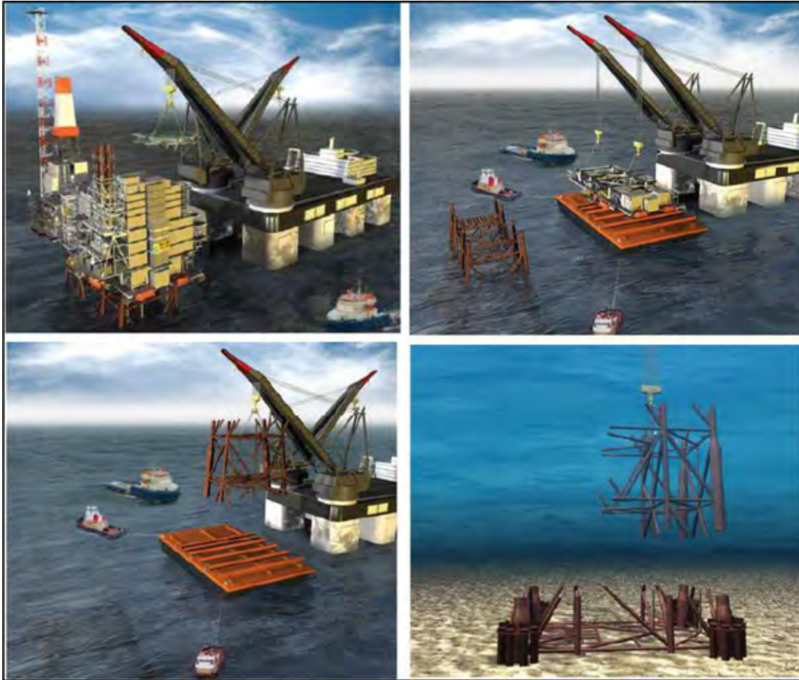
Figure 85 Étape de démantèlement d'une plateforme de production fixe (BP, 2011)
