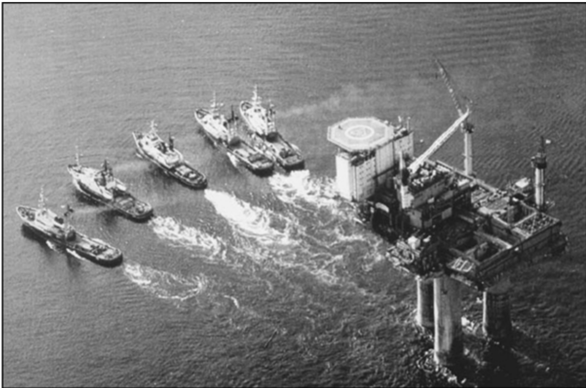
Figure 50 Remorquage d'une plateforme gravitaire d'exploitation d'hydrocarbures en mer du Nord (Gerwick, 2007)
