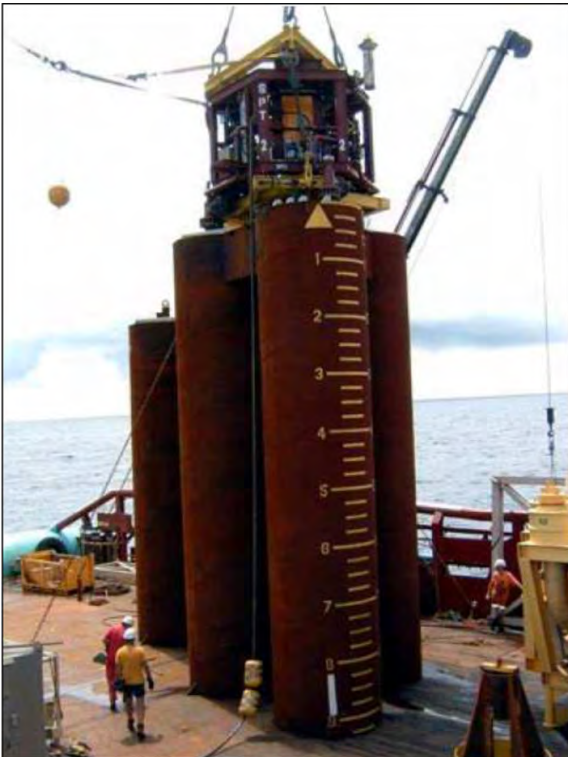
Figure 119 Fonçage de pieux par succion (« suction pile ») afin de réduire l'émission de bruit; gestion PD7 au tableau 51 (NCE, 2007)
