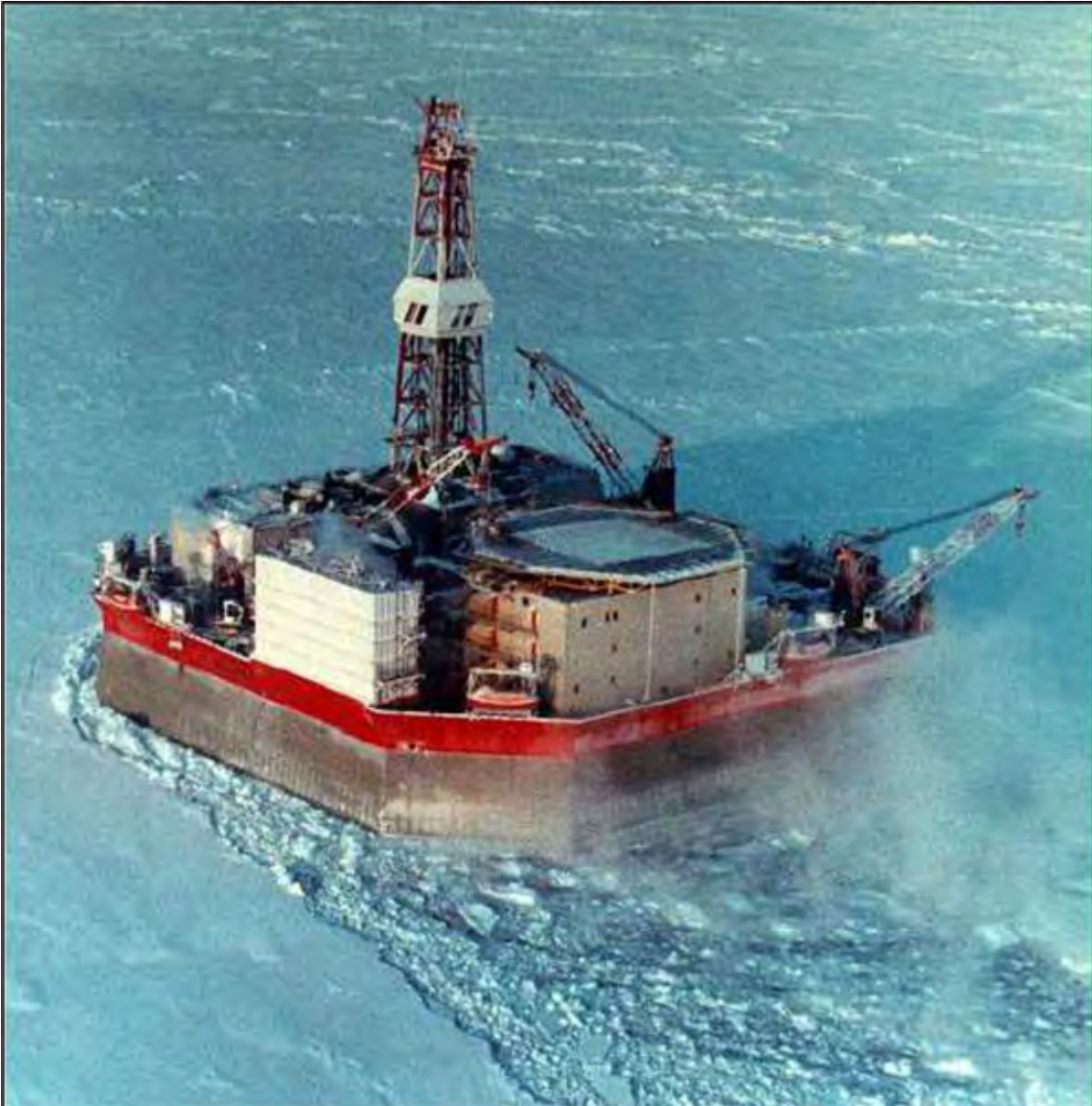
Figure 37 Structure gravitaire Molikpaq dans la mer de Beaufort; structure fonctionnelle à moins de 30 m de profondeur du fond marin; l'intérieur de la structure est remplie de sable (Callow, 2012)
