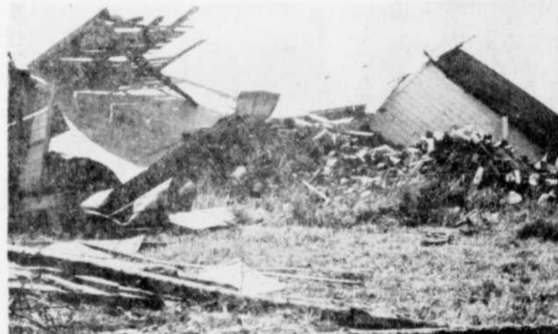
AMAS DE DEBRIS. — Il ne reste qu'un amas de débris de la grange et de la laiterie appartenant à M. Côme Boisvert, de Bromptonville. (Photo La Tribune, par Studio Breton)
