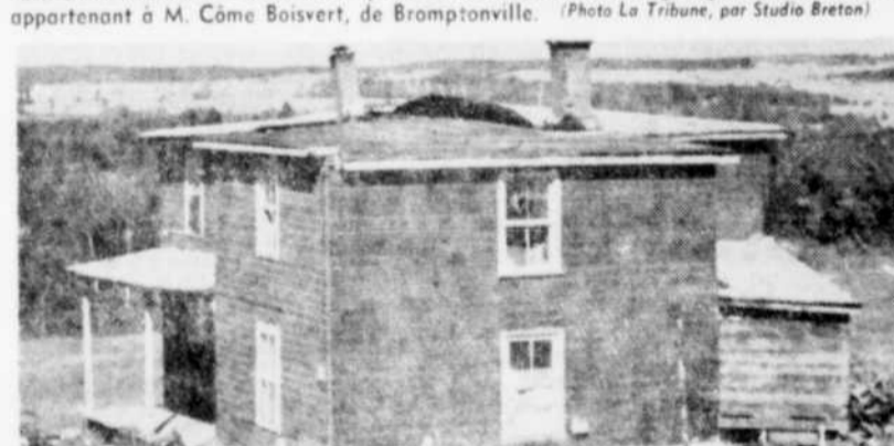
COUVERTURE EMPORTEE. — La couverture d'une maison abritant 10 personnes a été presque totalement emportée par les bourrasques qui se sont abattus sur la région de Sherbrooke. La cheminée de gauche est inclinée dangereusement. (Photo La Tribune, par Studio Breton)
