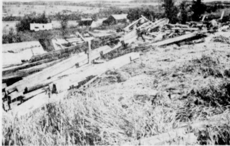
TOUT CE QUI RESTE. — C'est tout ce qui reste de la grange de M. J. Albert de Bromptonville, après le passage de la tornade. Cette grange abritait 30 bêtes à cornes. (Photo La Tribune, par Studio Breton)
