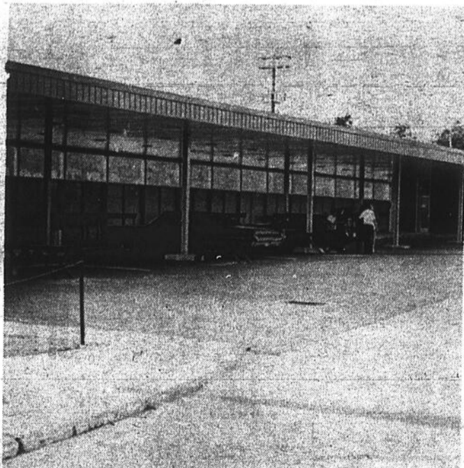
Afin d'augmenter l'efficacité du service des douanes un canapé pouvant abriter plusieurs voitures était récemment construit. Un tel outil de travail est indis-pensable pour examiner les voitures qui nécessitent un examen plus approfondi.
