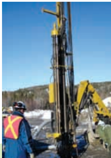
La foreuse pendant l'inspection.
