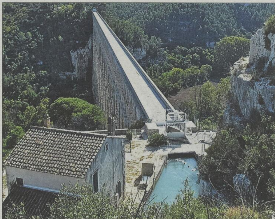
En montant au sommet du plateau, on peut voir les eaux du canal de Provence passer dans le troisième niveau de l'aqueduc.
