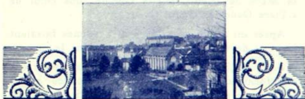
Vue générale du Bon Pasteur d'Angers.
