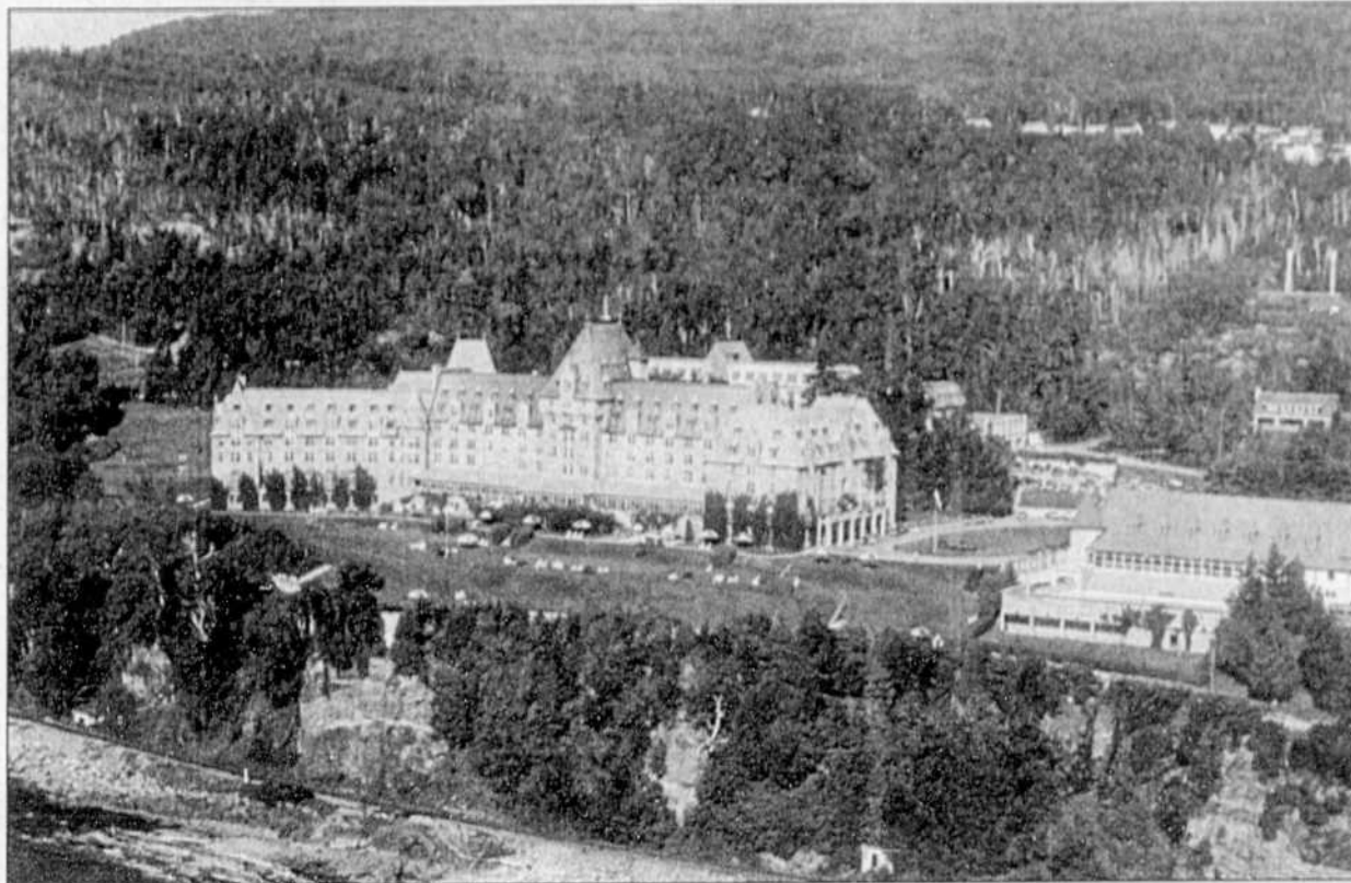
La venue du casino a stimulé dans la région le secteur de la restauration et de l'hôtellerie.
