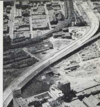
"La Route", prolongement de la rue Université. Ingénieurs-conseils (structure): Lalonde, Valois, Lamarre, Valois et assoc. Entrepreneur-général: Simard-Beaudry, Inc. Éléments précontraints: Francon (1966) Limitée.
