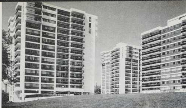
Immeuble de rapport Le Havre des Iles, Laval, Québec. Architectes: Warsaw Swartzman et Bobrow. Ingénieurs-conseils (structure): Spector, Barbacki, Forté, et associés. Entrepreneur général: Ain et Zakuta. Fournisseur de béton préparé: Premixed Concrete Ltd.
