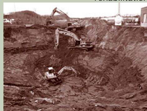
Une des trois excavations de six mètres de profondeur pendant les travaux de réhabilitation
