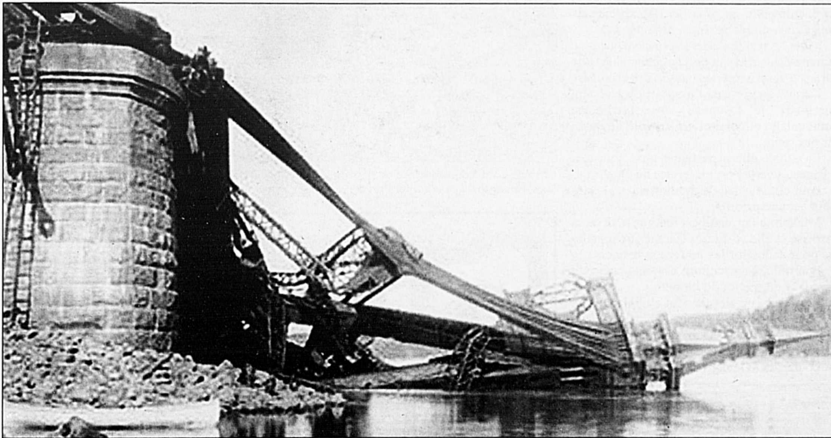
Les débris après le décrochage de la travée sud, qui a provoqué l'effondrement du pont de Québec et la mort de 76 personnes en 1907.
