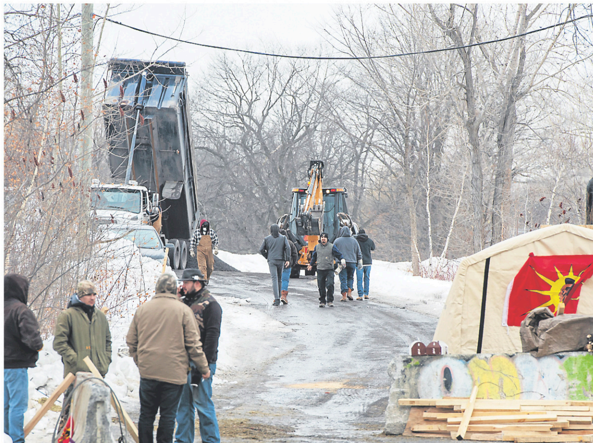
Sur le terrain mercredi, les Mohawks ont réagi à l'émission de l'injonction en renforçant le périmètre de la barricade par l'installation de murets de béton et le déversement de chargements de pierre. — RYAN REMIÖRZ, LA PRESSE CANADIENNE
