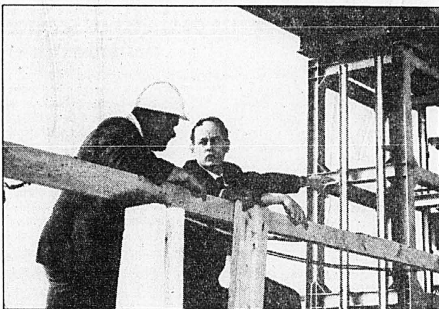
René Lévesque, en 1962, au barrage de Carillon.
