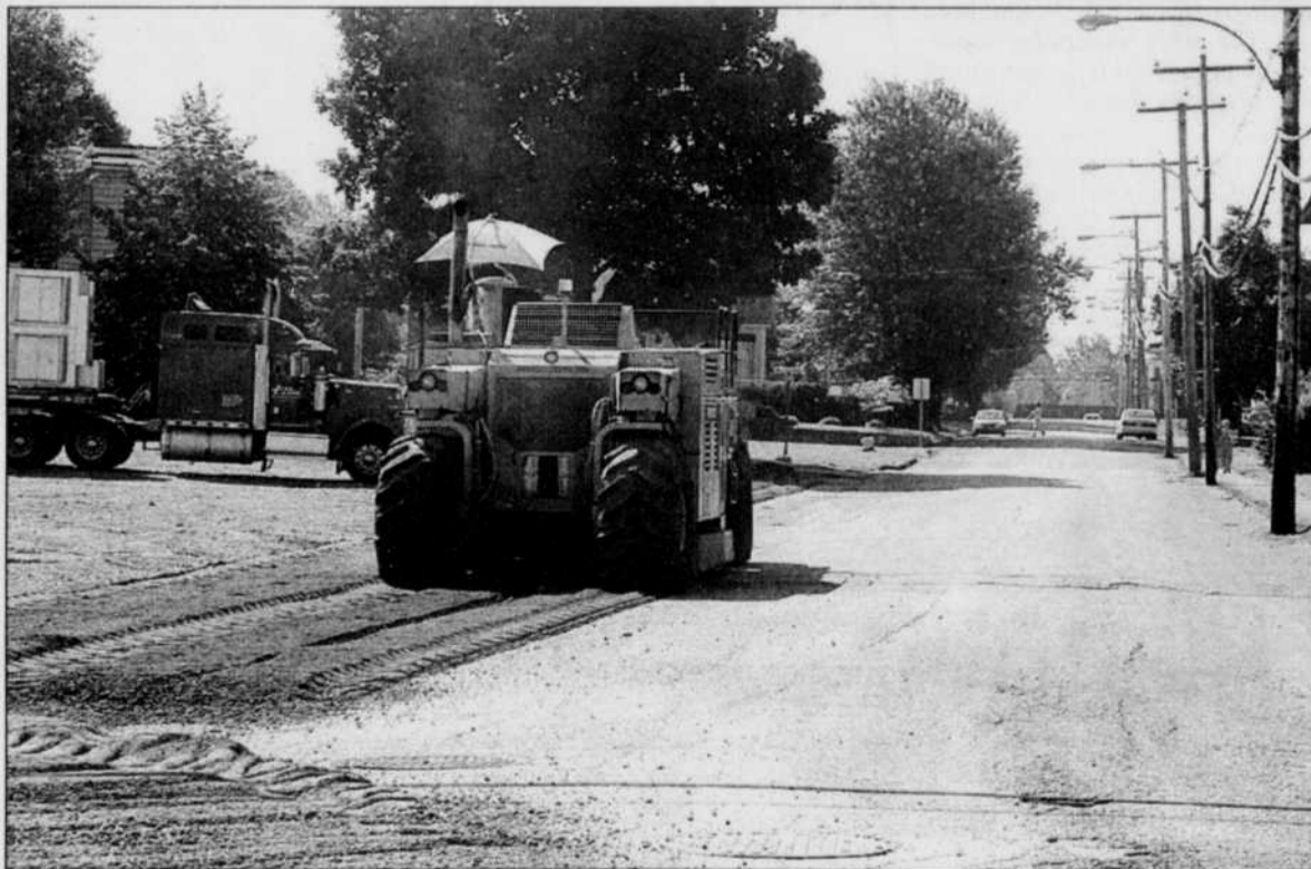
Les premiers branchements au réseau d'aqueduc devraient être effectués au printemps prochain.
