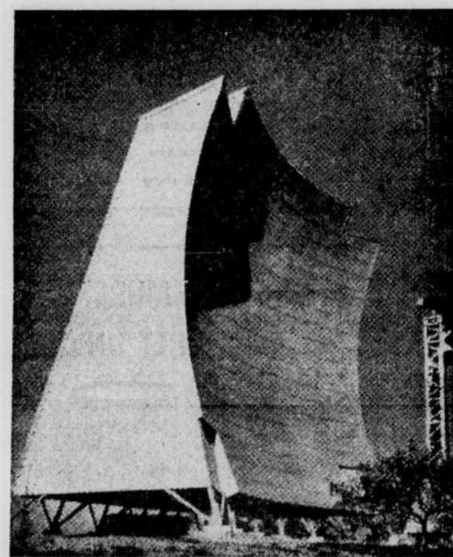
La forme de cette architecture ne doit rien à la création "gratuite" d'un artiste. Ce sont les exigences propres de cette antenne du réseau de communication de défense en Alaska qui lui valent cette belle forme dessinée par les ingénieurs des laboratoires du Téléphone Bell.
