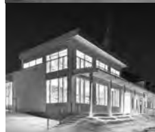
Ville de Château-Richer – Centre culturel Richard-Verreault - BIBLIOTHÈQUE MUNICIPALE DE CHÂTEAU-RICHER DG3A architecte (Agrandissement, recyclage, rénovation majeure et restauration patrimoniale) PHOTO : DAVE TREMBLAY
