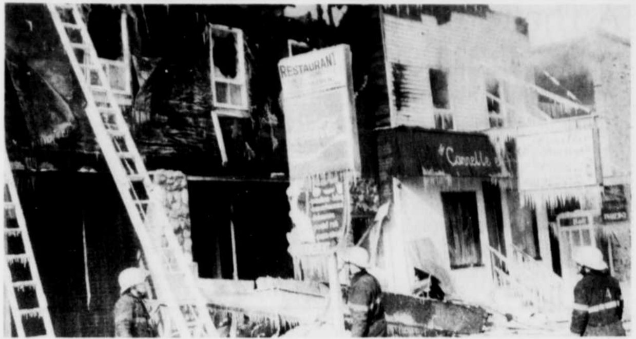
Un incendie a complètement détruit, tôt dimanche matin, deux édifices commerciaux à Richmond.
