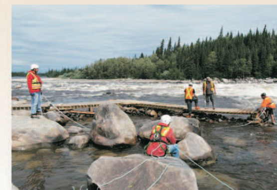
Travaux d'aménagement au site de Smokey Hill
