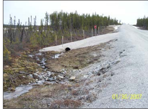
Rampe aménagée sur la route d'accès au seuil du PK 170 pour permettre la traversée de motoneiges
