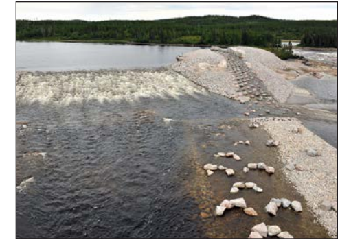
Frayère à esturgeon aménagée en aval du seuil du PK 290 (en bas sur la photo)
