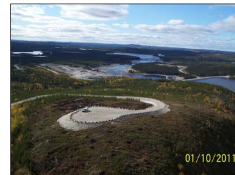
Chemin d'accès et plateforme pour le site commémoratif cri Rupert
