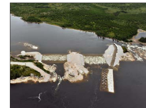
Aire d'accostage et stationnement (à gauche sur la photo) aménagés en aval du seuil du PK 290
