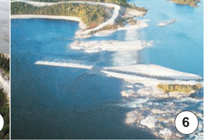
Seuil du PK 290
