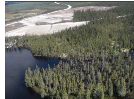
Route de construction maintenue sur le terrain R18 menant au seuil du PK 223
