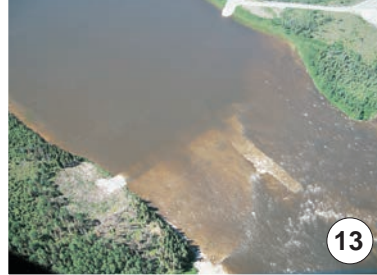
Tapis en enrochement du PK 20,4
