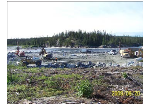
Construction du seuil du PK 223 par l'entreprise Newco
