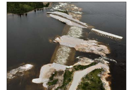
Point de vue au seuil du PK 290 (en bas de la photo, au centre)
