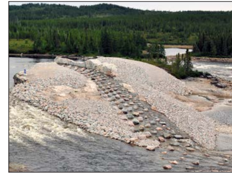
Chenal de montaison aménagé au seuil du PK 290
