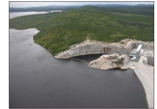
Estacade de navigation installée à l'entrée de l'évacuateur de crues Rupert
