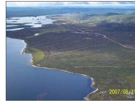
Déboisement multifonctionnel, vue d'ensemble à l'intersection des rivières Misticawissich et Rupert
