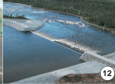
Seuil du PK 33
