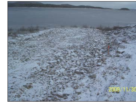
Rampe de mise à l'eau aménagée en amont du barrage de la Rupert
