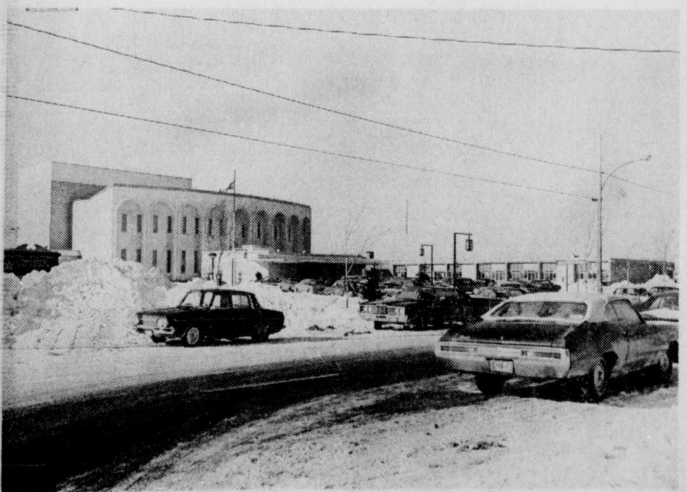
Vue extérieure du Centre culturel de Drummondville.
