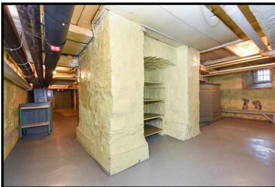
Figure 14. Vue du sous-sol abaissé et structure de l'aile de l'Apothicaiererie. Possible base de cheminée dans la portion est de l'aile. En direction ouest, photo Chantal Gagnon.
