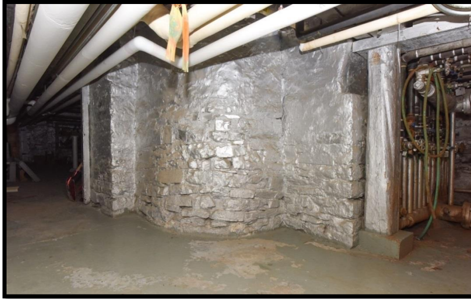
Figure 10. Massifs en maçonnerie, Bâtiment des Récollets. Côté sud de structures ajoutées à un mur de refend et visibles au sous-sol de l'aile. Vestiges probablement associés aux cuisines toujours en place au XVIII e siècle. En direction sud-ouest, photo Chantal Gagnon.
