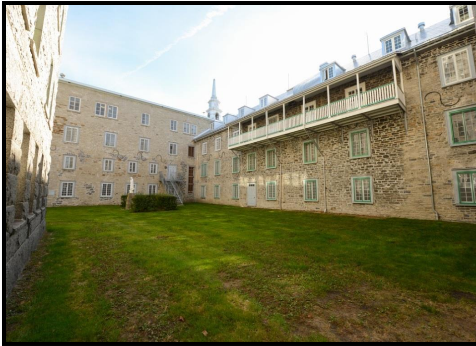
Figure 47. Vue de la cour à l'ouest du Bâtiment des Récollets (Jardin des Novices). Ce dernier est visible derrière la statue de la vierge avec la Première aile de la Communauté à droite. En direction est, photo Chantal Gagnon, # 815.
