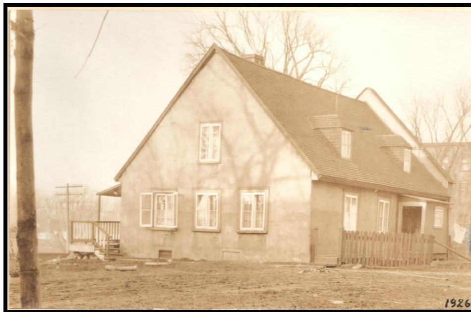
Figure 27. La maison des domestiques construite en 1738. Cette maison sera démolie en 1933 et une nouvelle maison destinée au contremaître a été érigée à quelques mètres de cet emplacement. Fonds du Monastère des Augustines de l'Hôpital Général de Québec, AMA.
