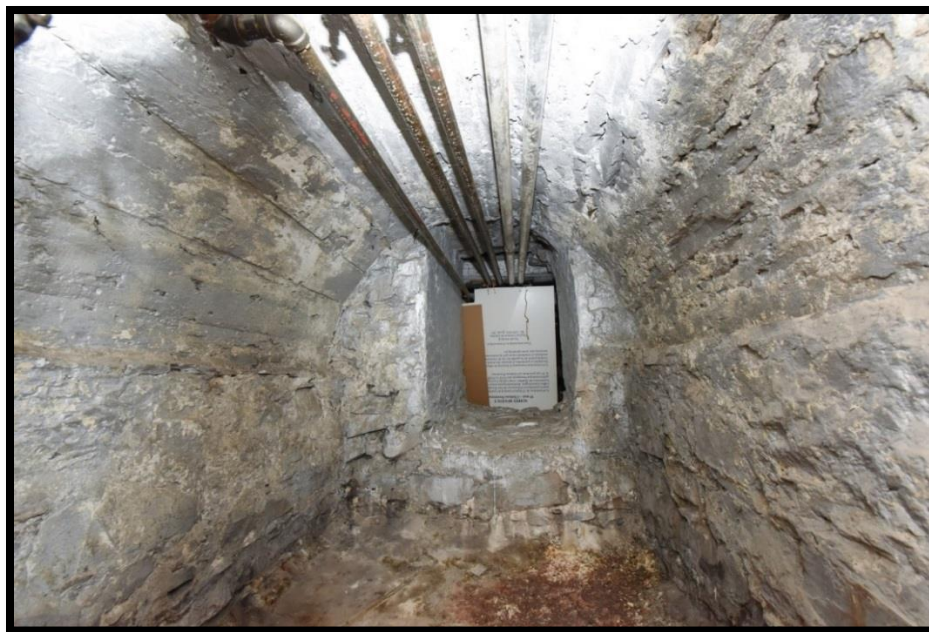
Figure 12. Arc de décharge ou voûte aménagée dans le mur de refend, Bâtiment des Récollets. Structure sous la section réfectoire/cuisines. En direction sud, photo Chantal Gagnon.
