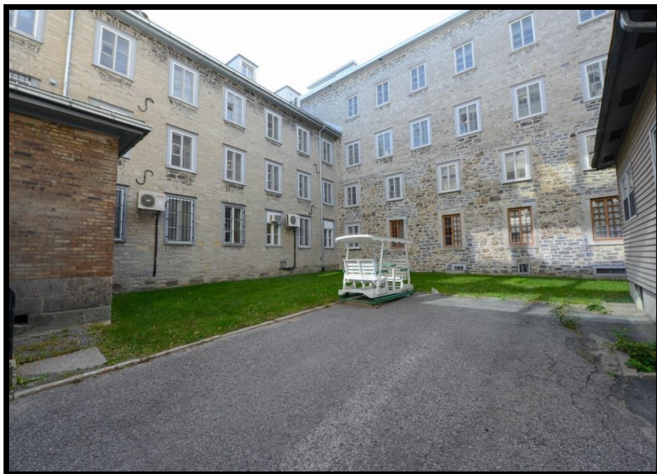
Figure 45. Vue de la cour près de l'Aile du Dépôt. En direction sud, photo Chantal Gagnon, # 851.
