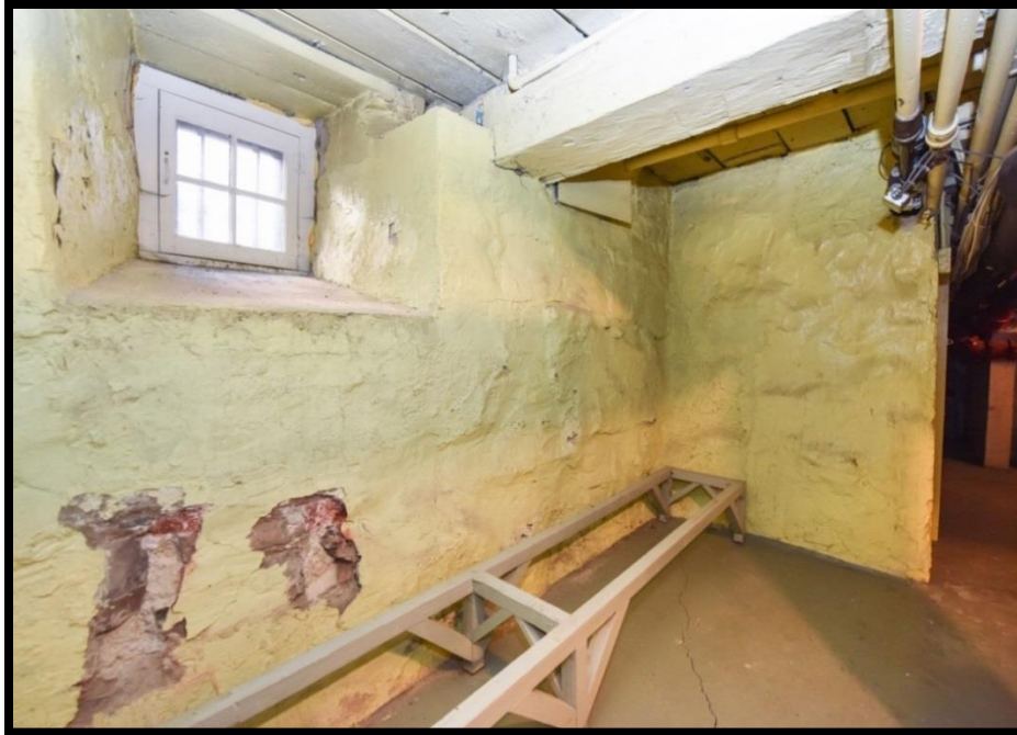
Figure 15. Fondation du mur nord de l'aile de l'Apothicaierie. En direction nord, photo Chantal Gagnon.
