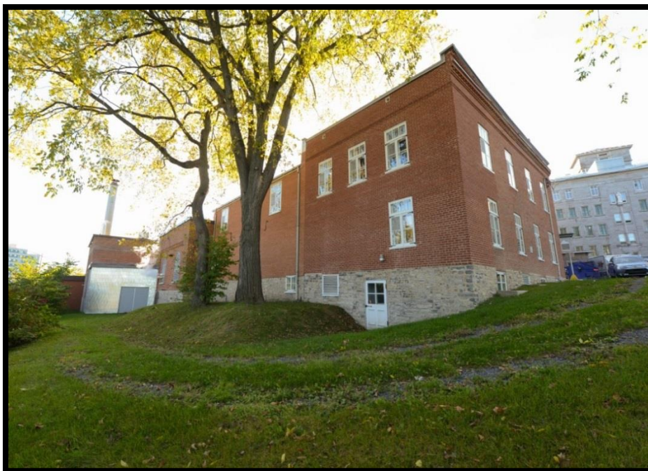
Figure 60. Vue des terrains situés à l'arrière des bâtiments de la buanderie. En direction est, photo Chantal Gagnon, # 646.
