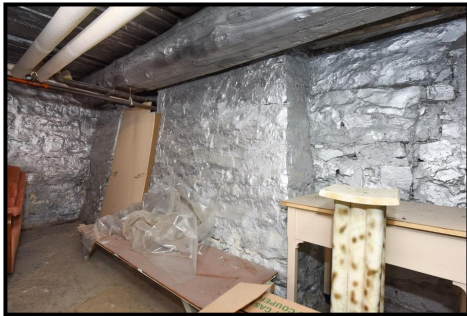
Figure 11. Parement du massif en maçonnerie, Bâtiment des Récollets. Base d'une structure en maçonnerie appuyée contre le côté sud de la fondation d'un mur de refend. En direction nord-ouest, photo Chantal Gagnon. Massifs de maçonnerie ajoutés à un mur de refend, Bâtiment des Récollets.
