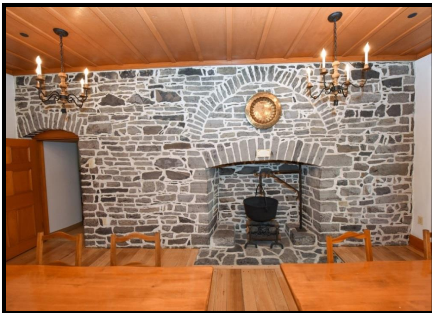
Figure 13. La grande cheminée restaurée au rez-de-chaussée de l'aile de l'Apothicaiererie. Photo Chantal Gagnon.
