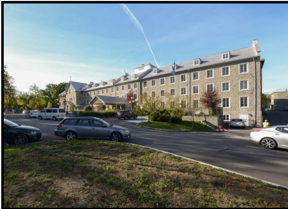
Figure 58. Façade de l'aile du Dépôt. Notez l'altitude du terrain plus bas que le stationnement situé devant l'aile de l'Hôpital. En direction ouest, photo Chantal Gagnon, # 704.
