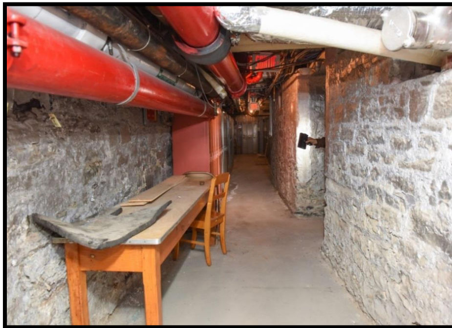
Figure 57. Intérieur du sous-sol de l'aile de l'Hôpital. Photo Chantal Gagnon, #380.
