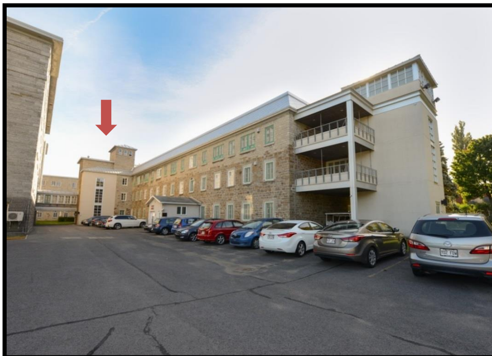
Figure 48. Vue de la cage d'escalier aménagée contre le mur nord de la Seconde aile de la Communauté. La passerelle aérienne mène à l'aile Saint-Joseph. En direction est, photo Chantal Gagnon, # 803.
