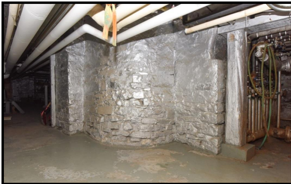
Figure 52. Massifs en maçonnerie sous le Bâtiment des Récollets. En direction ouest, photo Chantal Gagnon, # 3023.
