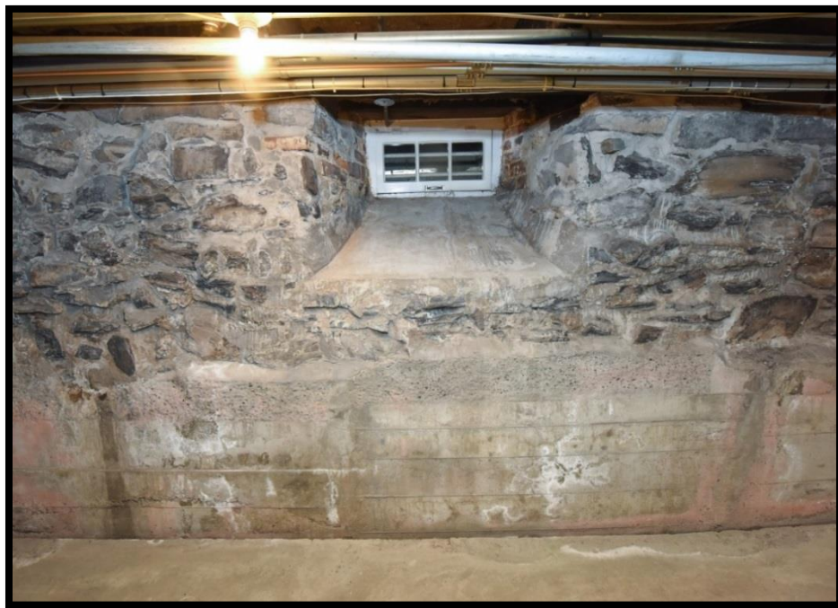
Figure 55. Exemple de fondations consolidées en sous-œuvre. Photo Chantal Gagnon, # 3020.
