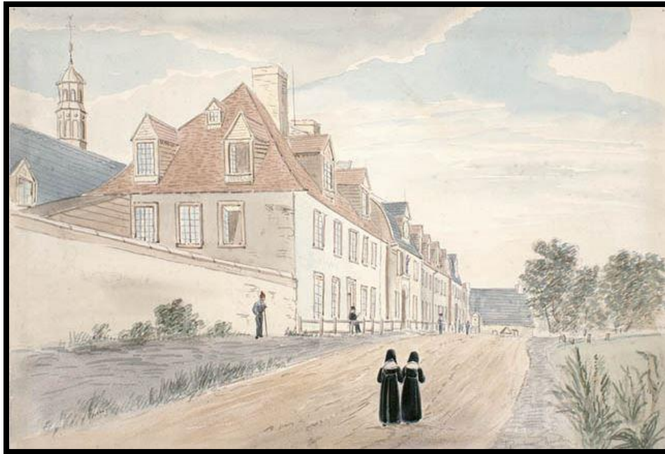
Figure 33. La façade de l'hôpital et le presbytère vers 1830. Notez le toit du bloc de latrines en appentis au coin sud-ouest du presbytère. Œuvre de James Pattison Cockburn, L'Hôpital Général à Québec, Bas-Canada. Bibliothèque et Archives Canada.
