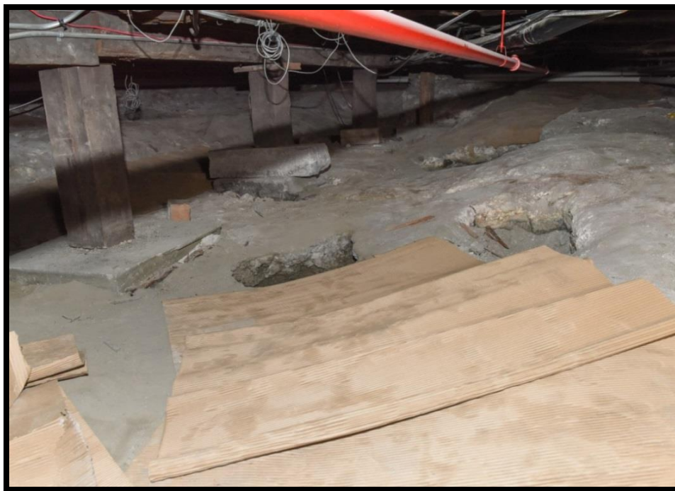
Figure 51. Le sous-sol de l'église Notre-Dame-des-Anges. En direction ouest, photo Chantal Gagnon, # 0338.
