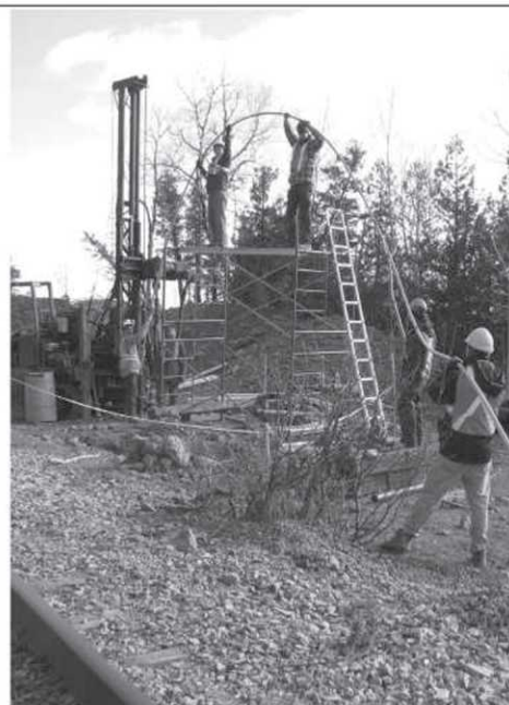
Mise en place d'instruments qui permettront la télésurveillance des mouvements du terrain le long de la voie ferrée, dans la région de Port-Daniel-Gascons.
