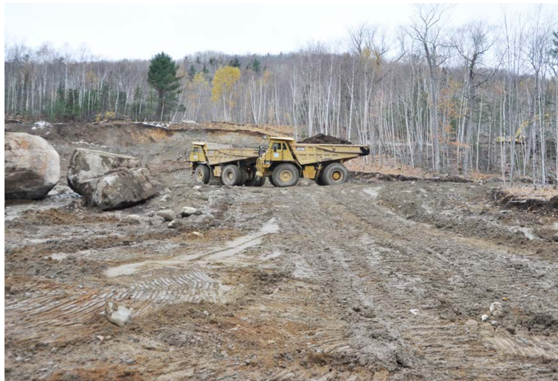
Les travaux vont bon train à la base de la montagne. Photo courtoisie
