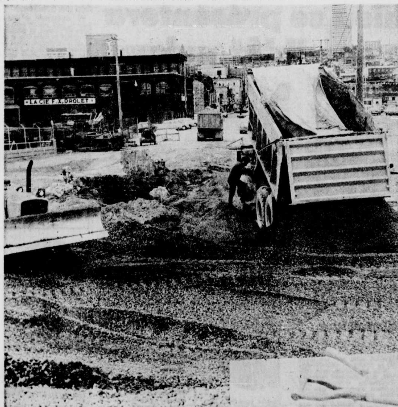
Les travaux progressent au pont Dorchester. On sait que le public n'a pu, depuis plusieurs mois, emprunter cette voie d'accès au "Vieux Québec", par-delà la St-Charles. Il est à espérer que les travaux seront complétés à l'automne, car plus d'un automobiliste est affecté par la lenteur de la circulation aux heures de pointe. Il ne fait pas de doute que l'ouverture de ce pont contribuera à améliorer le réseau routier en quelque sorte "déficient" de la capitale québécoise.
