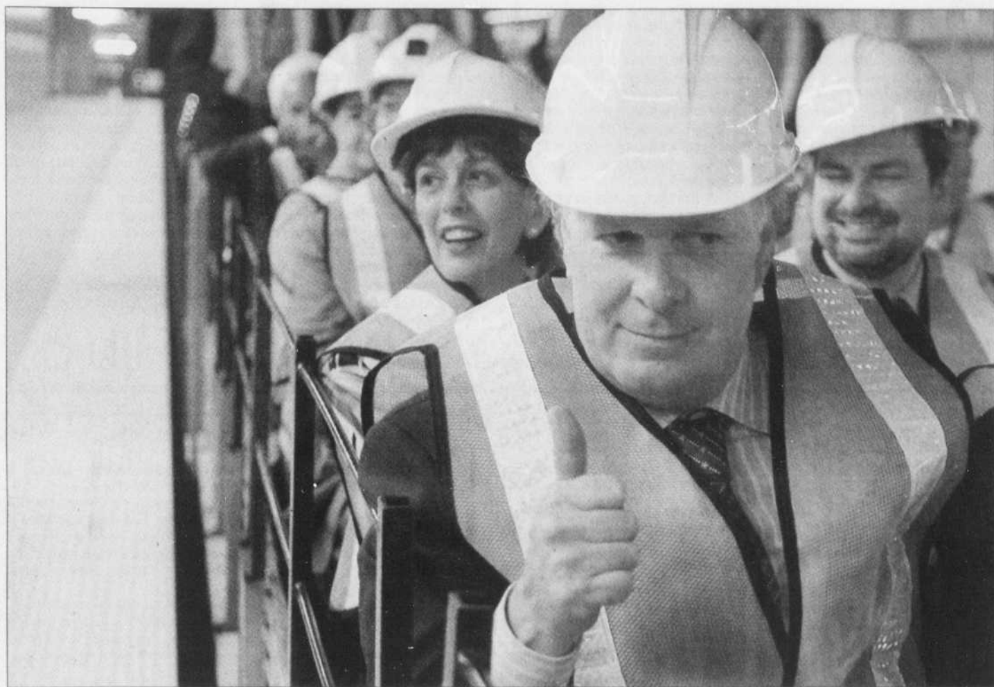
Jean Charest et plusieurs de ses ministres ont parcouru hier les nouvelles stations de métro présentement en construction à Laval.
