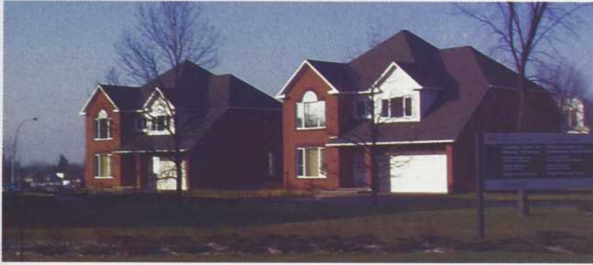
PHOTO : CENTRE CANADIEN DES TECHNOLOGIES RÉSIDENTIELLES Pour comprendre ce qui se passe à l'intérieur d'une maison, les ingénieurs ont construit deux maisons jumelles : l'une est habitée; l'autre, tel un laboratoire, est pleine de capteurs. Ces données servent à comprendre les variations de température, d'éclairage, etc.
