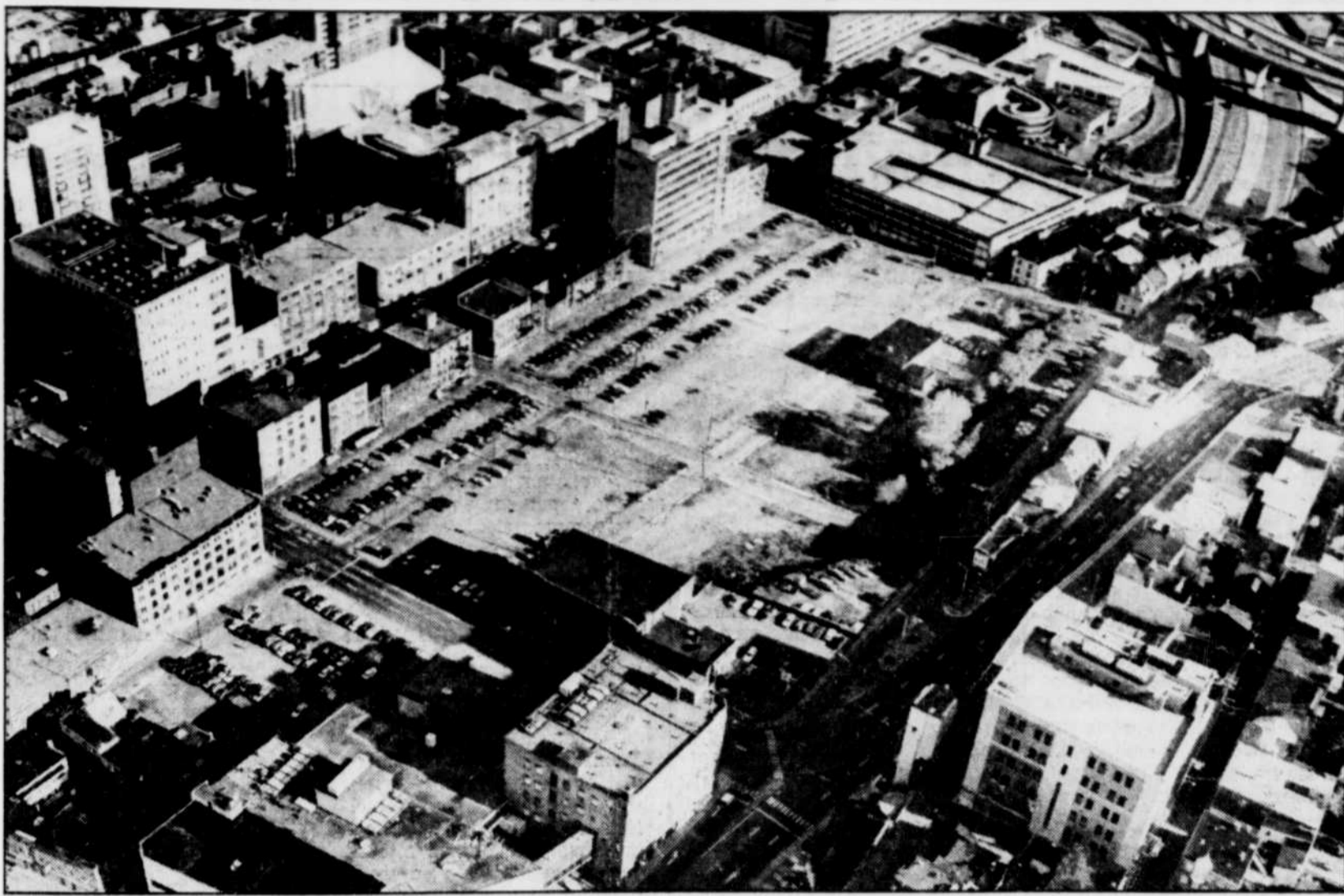
En vue de l'aménagement de la « grande place » et la construction d'un tunnel, la ville de Québec se prépare à fermer des parties de rues dans ce secteur.
