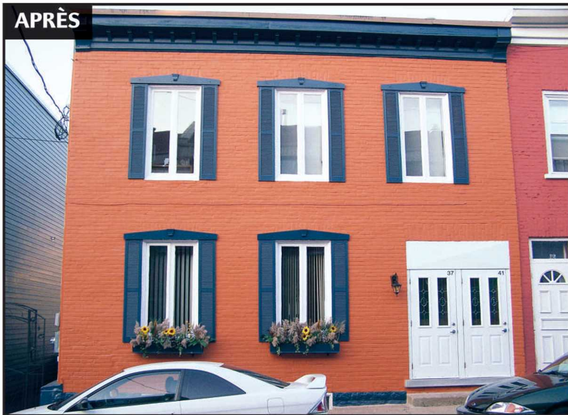
La devanture de l'immeuble de la rue Bigauette une fois rafraîchie. Les principaux changements : une nouvelle couleur, l'ajout de volets, de linteaux et de boîtes à fleurs.
