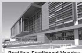
Pavillon Ferdinand-Vandry 1050, avenue de la Médecine Arrondissement de Sainte-Foy-Sillery Agrandissement
