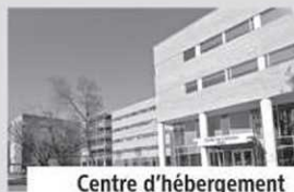
Centre d'hébergement et CLSC de Limoilou 1401 et 1405, chemin de la Canardière Arrondissement de Limoilou Rénovation
