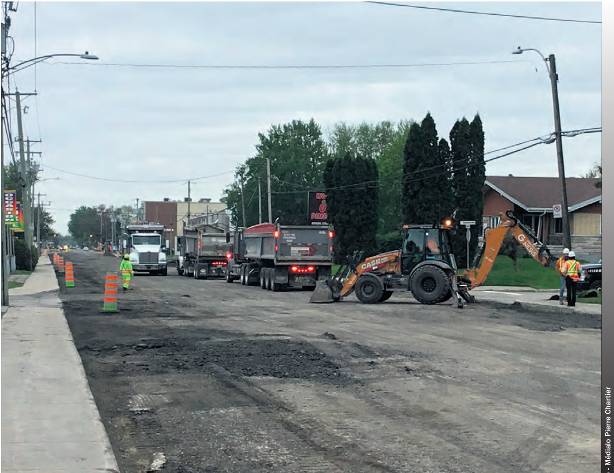
Travaux sur la rue Notre-Dame (entre Prud'homme et Saint-André).
