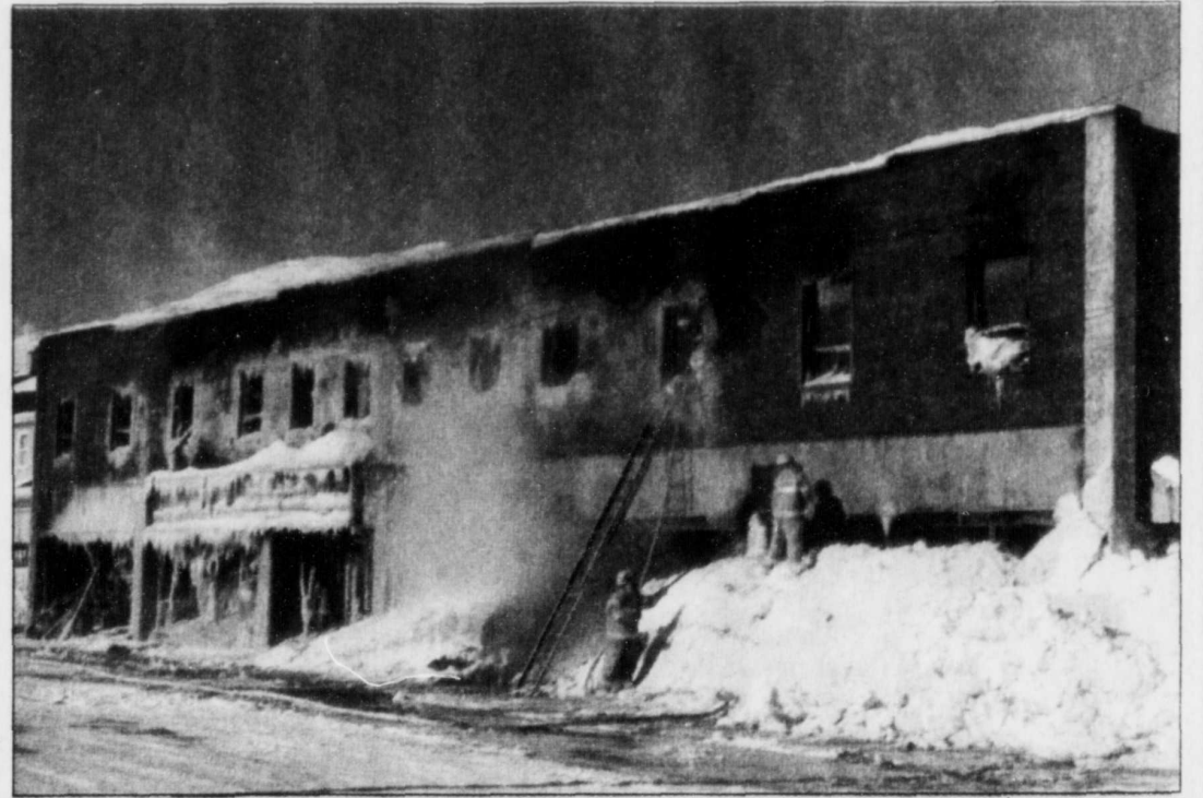
Immeuble de la 4 e rue a été complètement détruit par les flammes. Hier midi, de la fumée s'échappait toujours de la bâtisse et ce, malgré des efforts intensifs des sapeurs et des employés municipaux.
