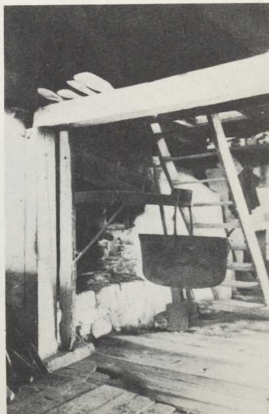
Figure 77. — Chaudron et brimbale (four à pain débouchant dans la même cheminée).
