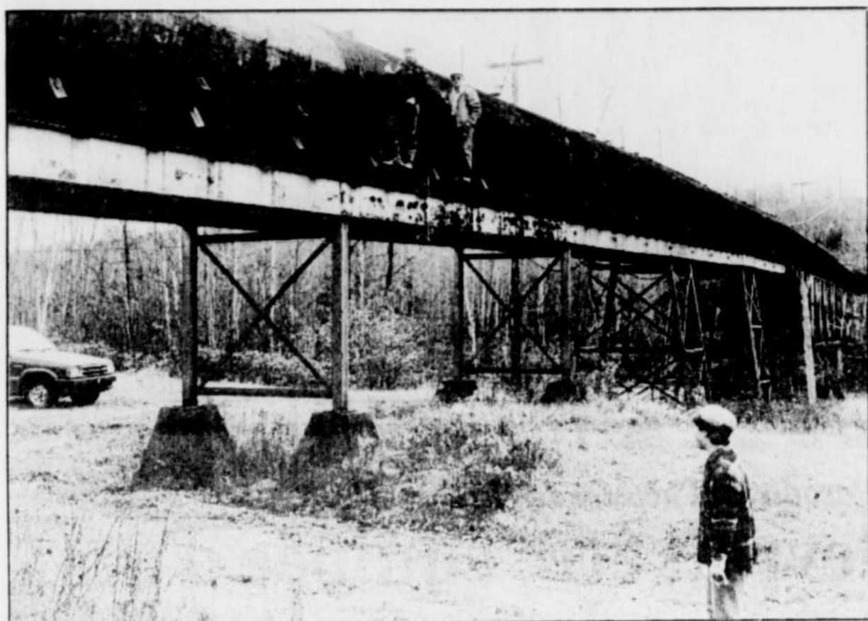
Certains citoyens de Saint-Raphaël ne désespèrent pas de voir, un jour, la remise en activité de la centrale qu'Hydro-Québec a abandonnée, il y a quatre ans, alors qu'elle enregistrait encore un surplus d'énergie.
