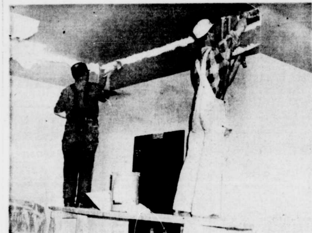
LE GREFFE DE LA COUR de Magistrat sera renoué, grâce à des appropriations d'environ $1.500 prévues sur le dernier budget de la cité. On voit ici MM. Lucien Gelinias, plâtrier, et Jean-Guy Ricard, peintre, en train de refaire le plâtre en vue d'appliquer les couches de peinture nécessaires pour compléter le menage. Le bureau personnel du greffier, M. Anatole Rainville, aura aussi la visite des plâtriers, peintres et poseurs de tuiles de linoléum.
