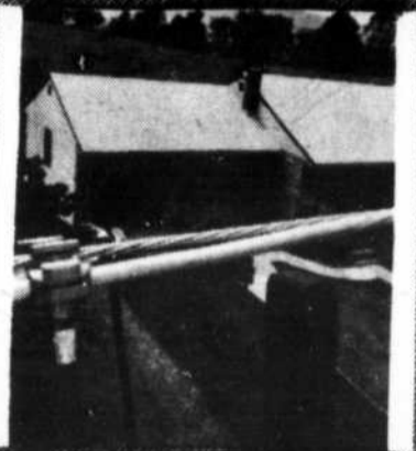
Le raccordement d'un abonné commence par l'installation d'un connecteur spécial sur le câble coaxial placé sur les poteaux.
