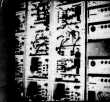
L'intérieur de la bâtisse renferme de l'équipement électronique très complexe qui filtre et amplifie les signaux des 10 stations de TV.
