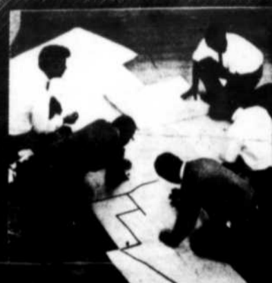
Une fois le site des antennes choisi, des plans détaillés sont préparés pour l'installation des câbles de télévision.
