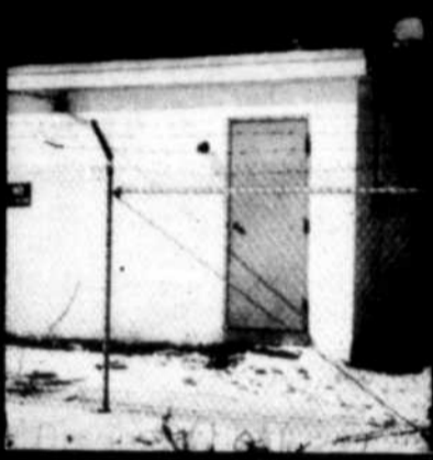
Le centre électronique du système est localisé dans cette bâtisse située tout près des antennes.
