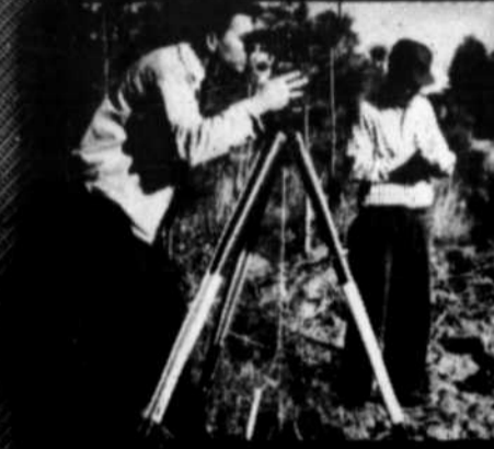
Des arpenteurs établissent exactement l'emplacement des tours pour les antennes.
