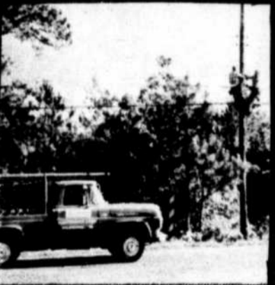
Un câble supporteur en acier est placé en tension entre les poteaux. Ce câble supportera le câble de télévision.
