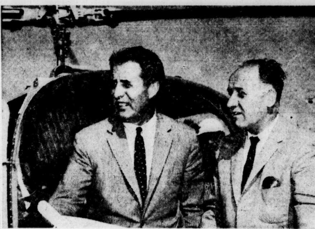
M. George Hees, ministre des transports, et M. Guy Beaudet, à droite, gérant du port de Montréal, ont visité hier les travaux du pont Champlain, à l'île des Soeurs. Ils étaient accompagnés d'ingénieurs et de journalistes.
