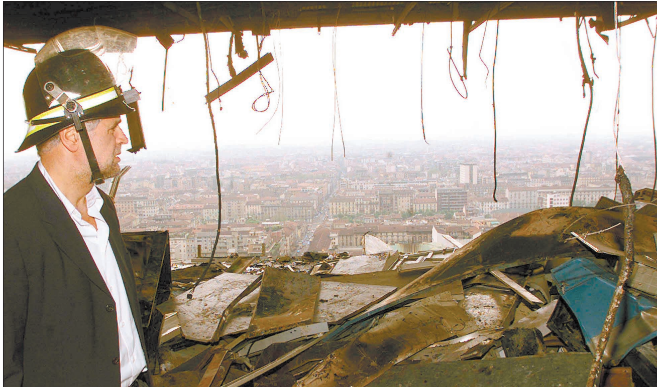
Le président de la Lombardie, Roberto Formigoni, examine les dégâts de l'intérieur de la tour.
