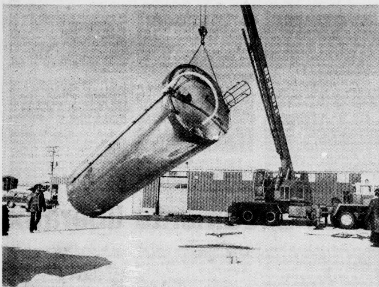
L'installation de l'un des 3 silos à l'usine Bovac
