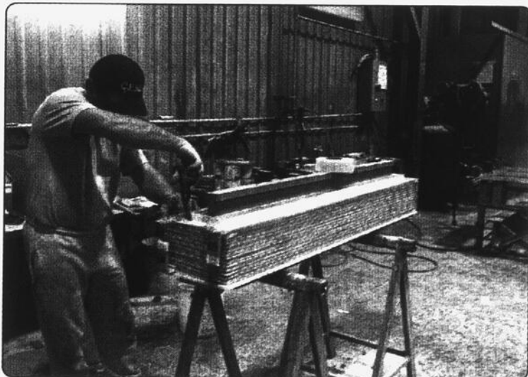
Un employé de CEMI au travail. Les activités de l'entreprise dépendent de la réfection des centrales hydroélectriques.
