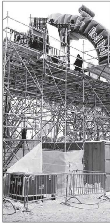
«Ça fait quatre semaines qu'on a de la construction dans notre rue. Ce n'est pas fini encore», se plaint une citoyenne qui demeure en face du parcours de glace. — PHOTOTHÈQUE LE SOLEIL, ERICK LABBÉ
